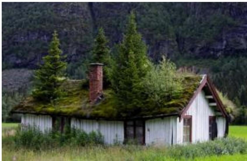
**Figure 6 : Une toiture végétalisée, appelée « sod roof », en Norvège (source: Shimmin, 2012)**
