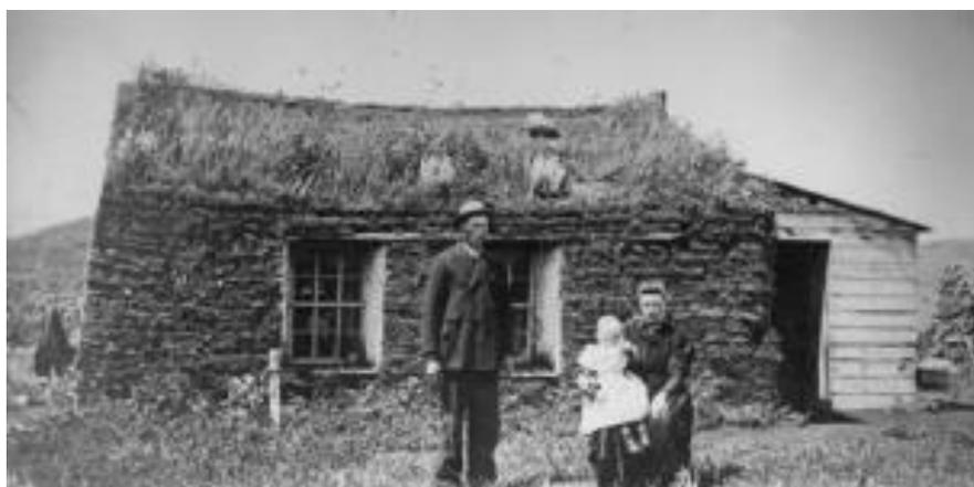
**Figure 7 : Une toiture végétalisée (« sod roof ») à Milton au Dakota du Nord construit par un immigrant norvégien (source : Shimmin, 2012)**
